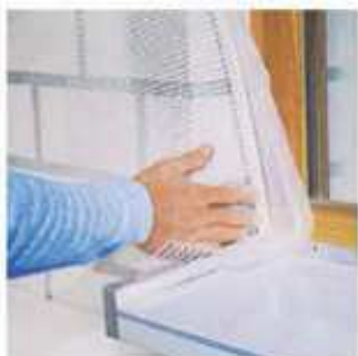
Връзка на топлоизолацията с подпрозоречна дъска
