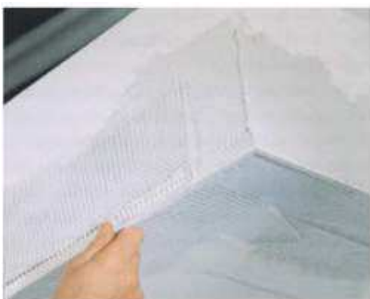
Заработка на водооткапващ профил
