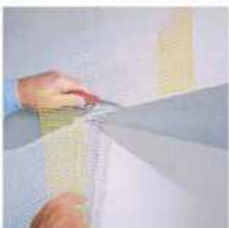
Връзка на топлоизолацията с подпрозоречна дъска
